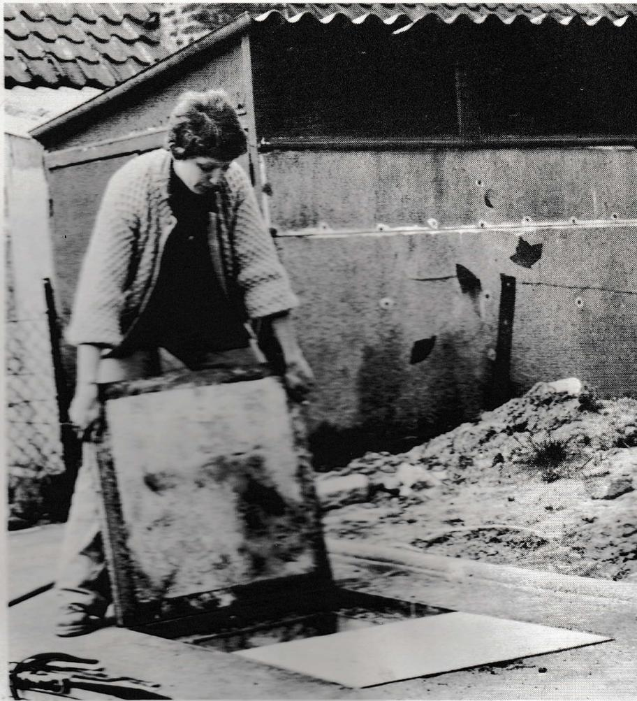
Soulever une plaque de chambre de raccordement.
